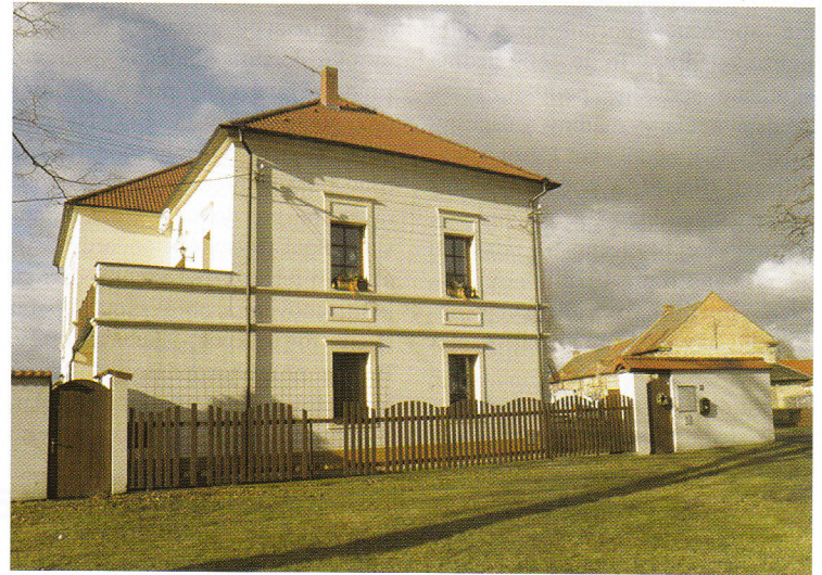
Opravený statek v Mnetěši je dominantou.
